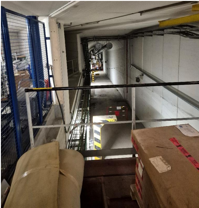
Kuva 31 Vanha infrastruktuuri on uusiokäytössä.
