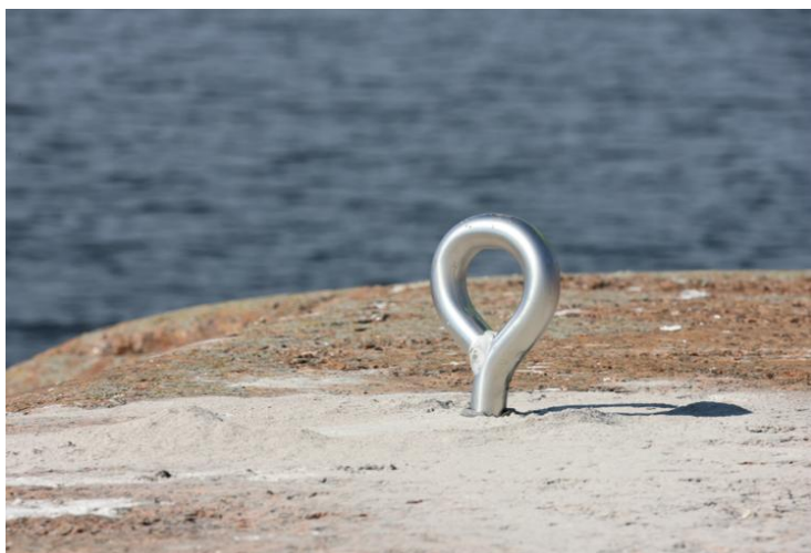
Kuva 5 Asennettu kallioankkuri.
